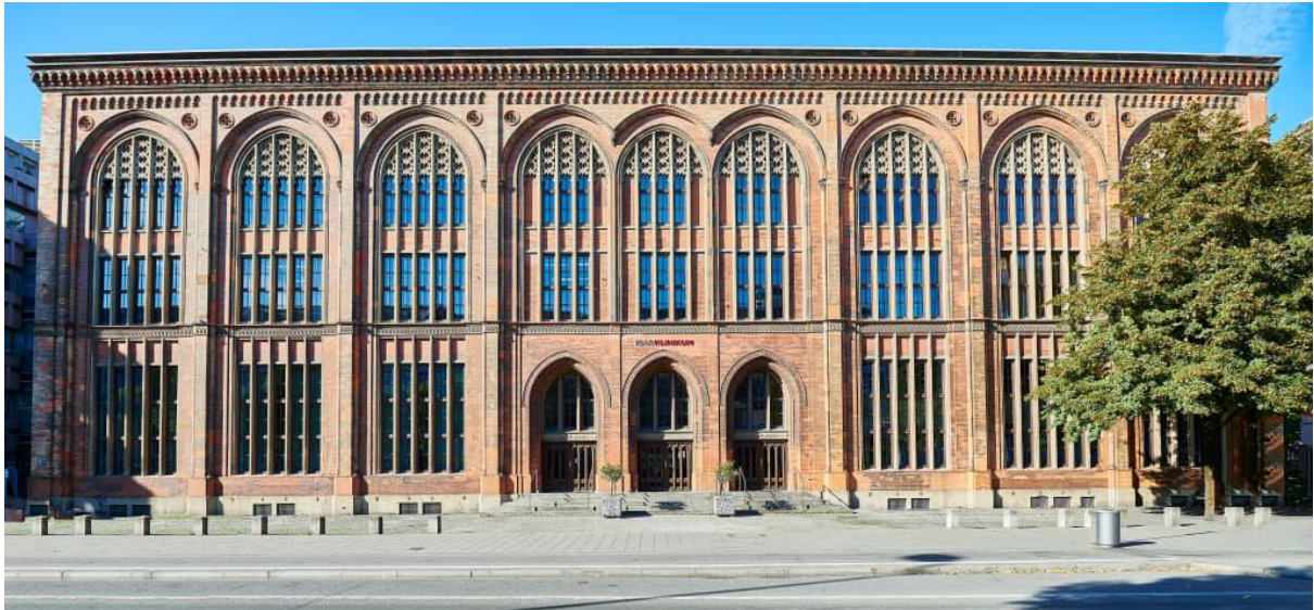
Abbildung 1: Ansicht ISAR Klinikum Bürklein Bau
